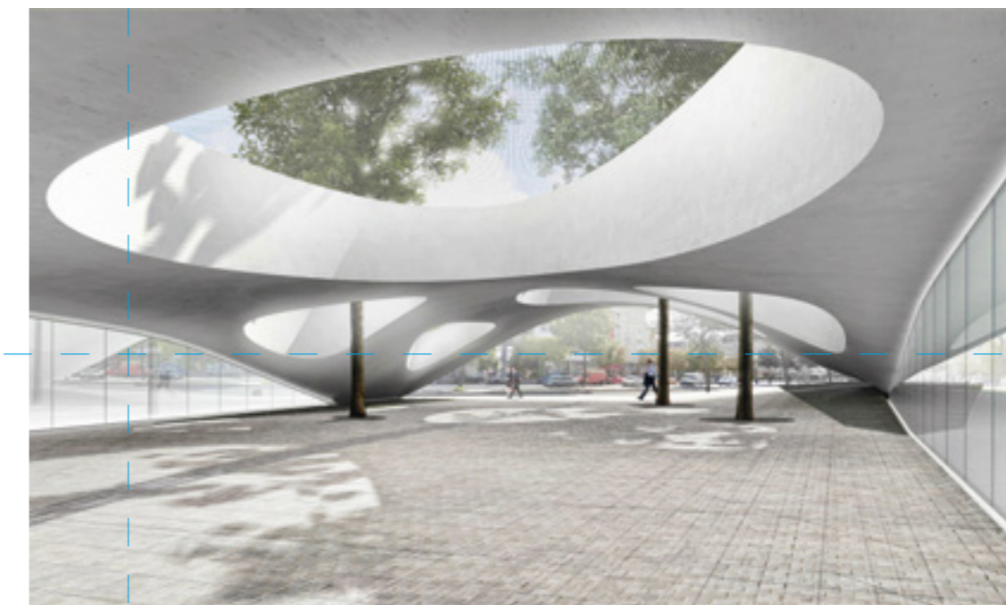
De larges ouvertures dans la toiture éclairent naturellement la gare
