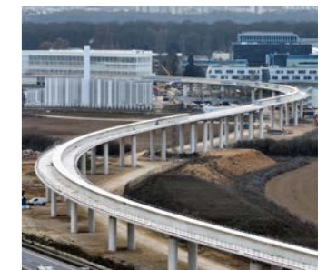
Le viaduc de la ligne 18 à Palaiseau
