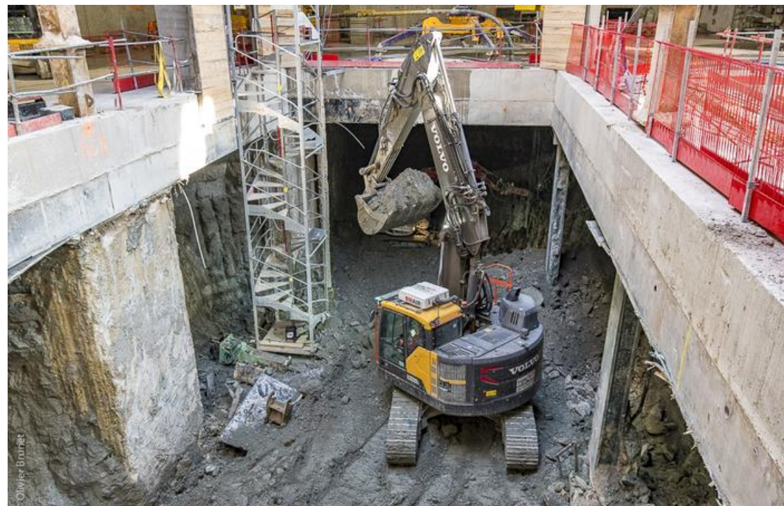
Excavation à la pelle hydraulique - SGP / Olivier Brunet
