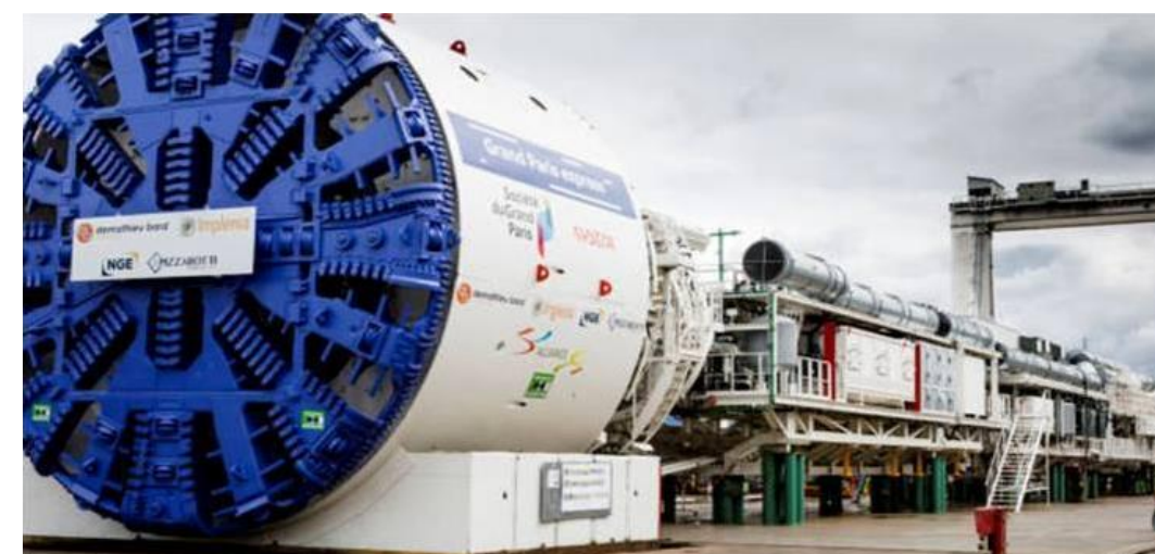
Tunnelier de Champigny avec une partie du train suiveur à droite - SGP / Laurent Villeret
