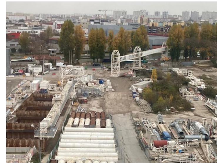
Mise en place de la bande transporteuse entre le puit Agnès et le canal de Saint Denis - SGP (2022)
