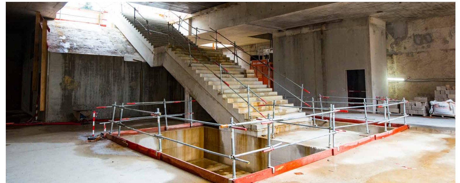
De la surface jusqu'au second niveau souterrain, l'escalier central prend place dans la gare en attendant les futurs voyageurs !
