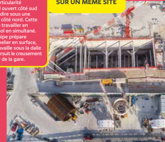
DEUX TECHNIQUES DE CREUSEMENT SUR UN MÊME SITE
