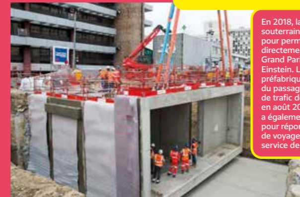
UN NOUVEAU PASSAGE SOUTERRAIN
