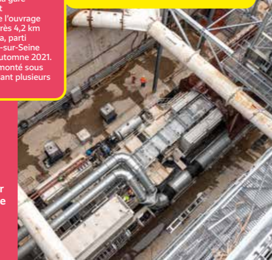
CAMILLE ET MARINA: DEUX TUNNELIERS EN ACTION
