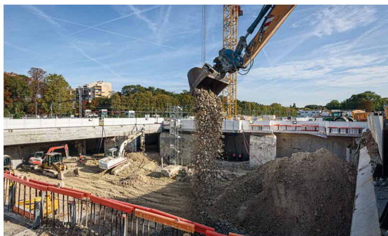
La partie centrale de la gare a été creusée à ciel ouvert jusqu'au premier niveau souterrain.
