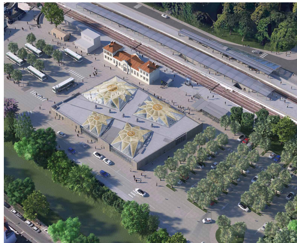
Au sud des voies ferrées, le futur bâtiment voyageur sera situé face à celui de la gare RER B Sevrans - Livry.
