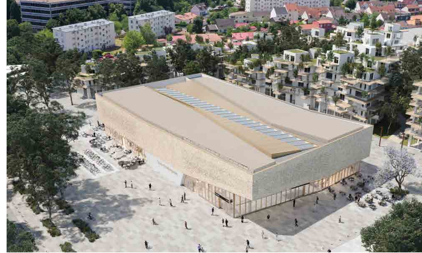
L'utilisation de la terre cuite dans un parement en relief symbolise la matière qui a été excavée du sol pour laisser place à la gare.
