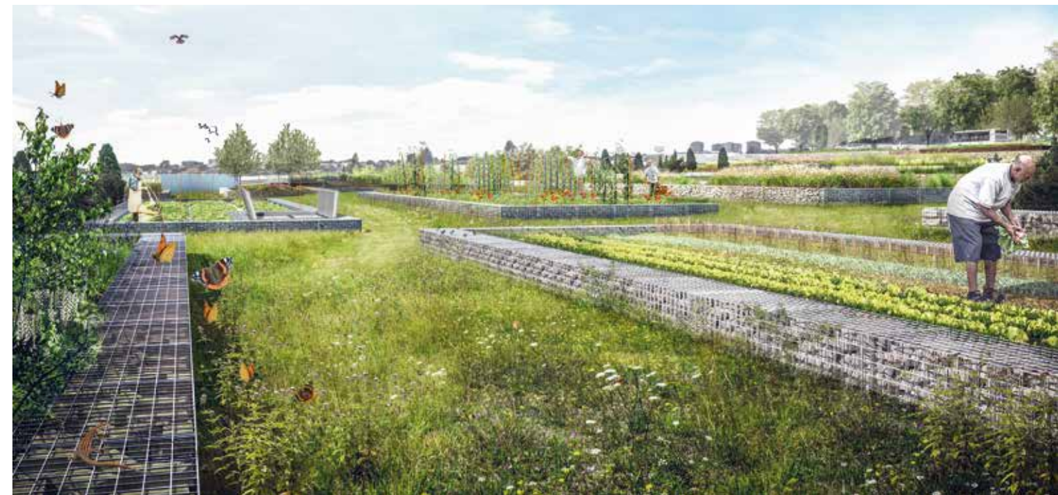
Toiture végétalisée du SMR
